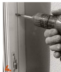
4. Fixation du nouveau dormant par vérins réglables ou par vissage en applique et réalisation d'une étanchéité périmétrale.
