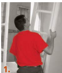
1. Dégondage des ouvrants.
